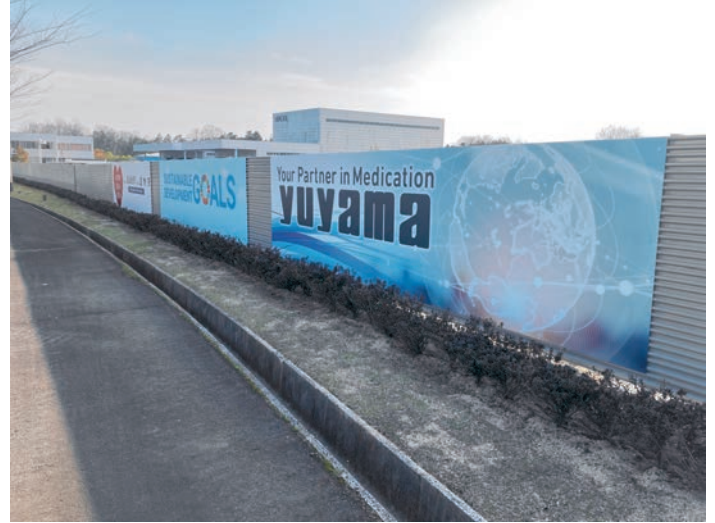
▼フェンス外観
